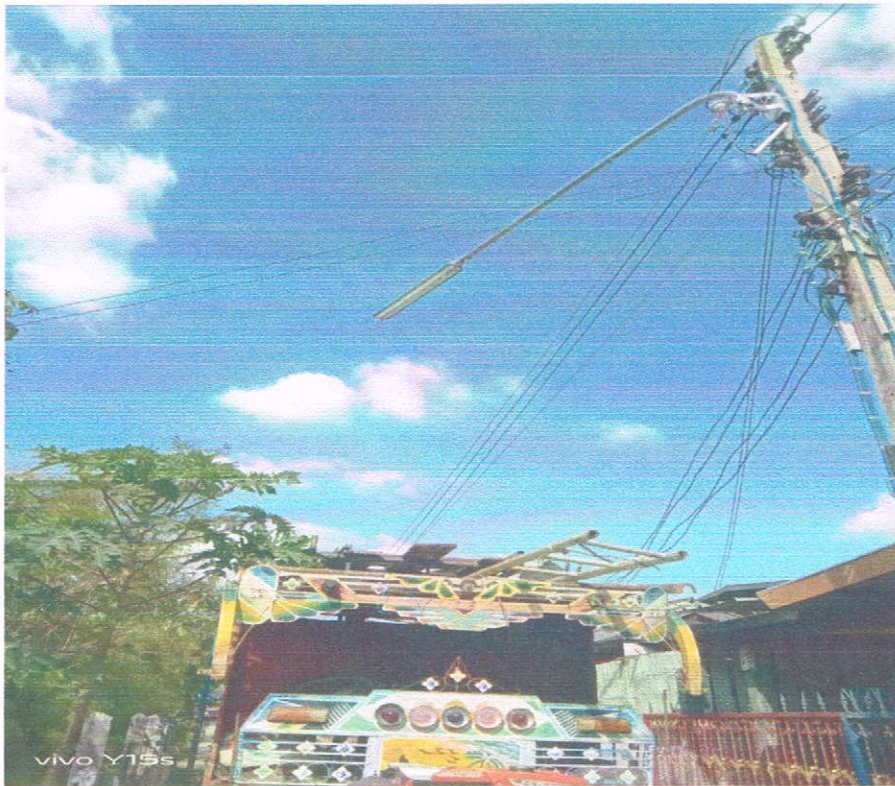
รูปภาพโครงการซ่อมแซมไฟฟ้าสาธารณะภายในตำบลหนองตาดใหญ่ หมู่ ๑ - ๙
