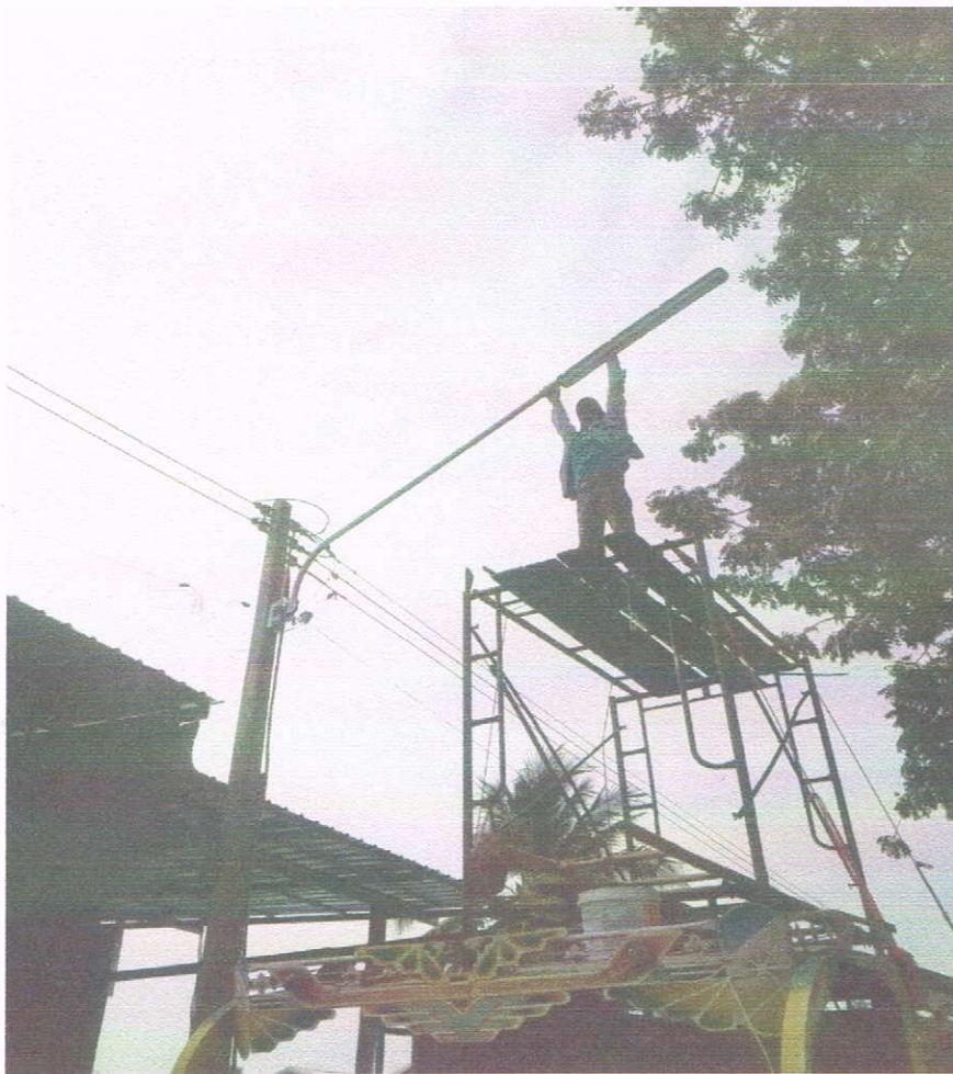
รูปภาพโครงการซ่อมแซมไฟฟ้าสาธารณะภายในตำบลหนองตาดใหญ่ หมู่ ๑ - ๙
