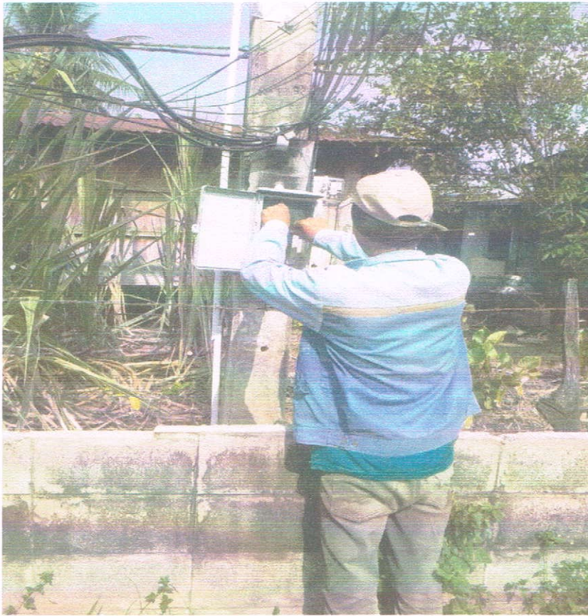
รูปภาพโครงการซ่อมแซมไฟฟ้าสาธารณะภายในตำบลหนองตาดใหญ่ หมู่ ๑ - ๙
