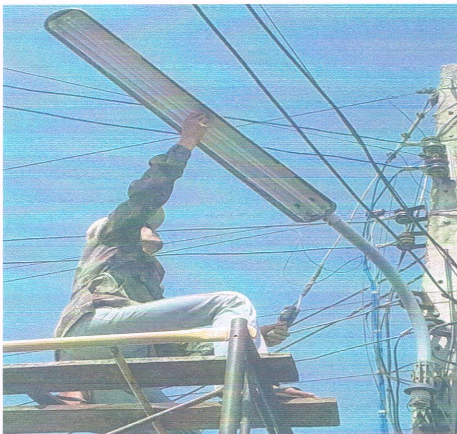
รูปภาพโครงการซ่อมแซมไฟฟ้าสาธารณะภายในตำบลหนองตาดใหญ่ หมู่ ๑ - ๙
